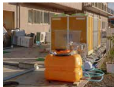
能登半島地震 福祉の杜わじま 貯水槽から上水を引込み、シャワー 排水を浄化してから側溝に排水
